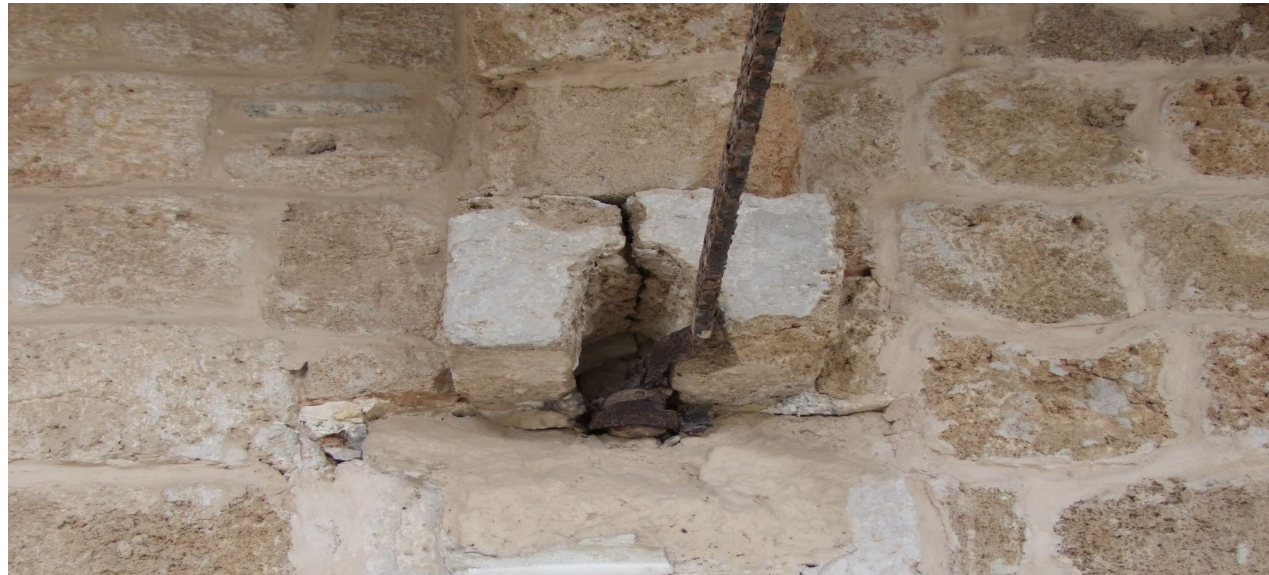
تشققات في أحد التيجان التي تدعم قبة في الرواق، وصدأ في العارضة
